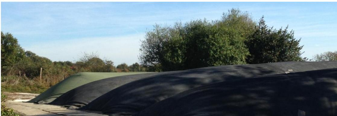
Figure 3 - Les digesteurs du GAEC du Bois Joly : des silos en béton couverts d'une membrane
