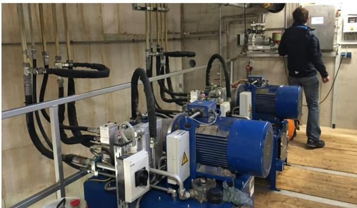
Figure 21 - Le système hydraulique pour le brassage
