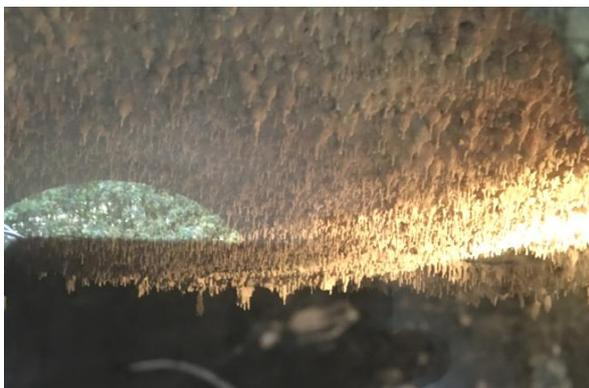
Figure 13 : Stalactites de soufre à l'intérieur du digesteur
