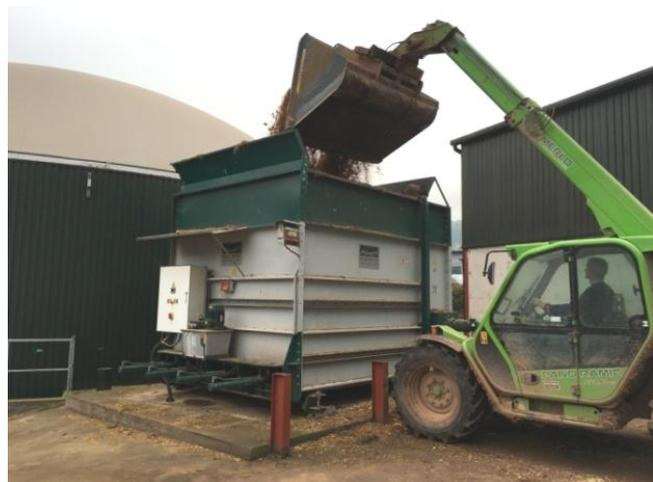
Figure 12 : Trémie d'incorporation, installation PlanET Biogas. Tous les substrats sont pesés pour le suivi de l'installation
